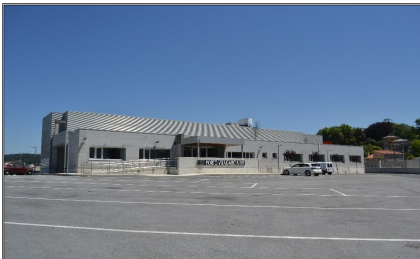
Punto de Inspección Fronteriza
