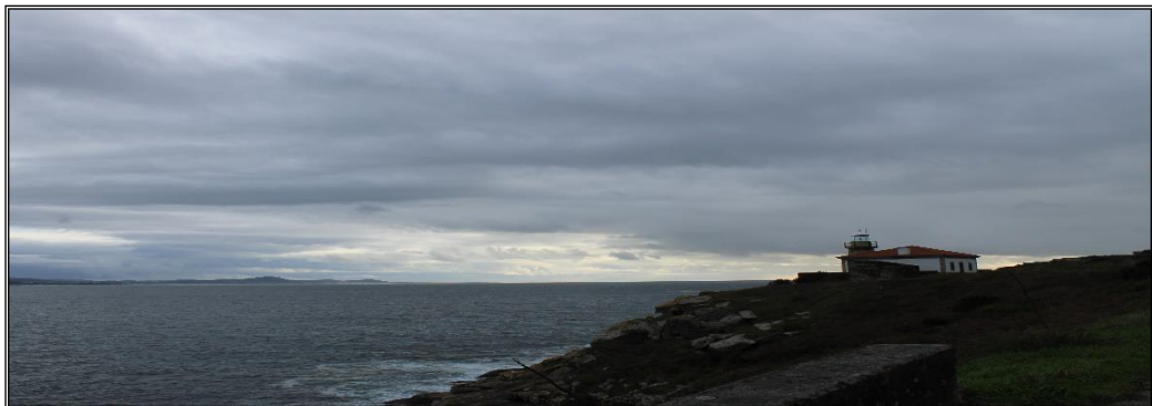
Faro de Monte Louro. Muros
